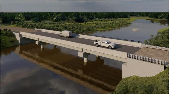
La obra proyectada para el cruce sobre el río Luján en reemplazo de la estructura existente está basada en las cotas de fondo de viga y luz hidráulica que ha determinado la Dirección Provincial de Hidráulica, correspondiéndose con el plano C-II-2011.
